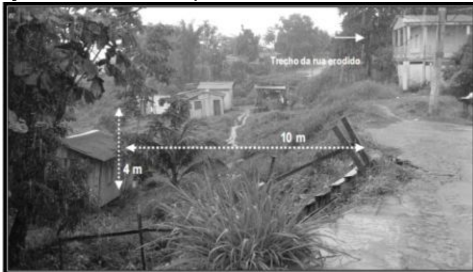
Residências em área de risco Foto: Frank Arcos - jan/2012
