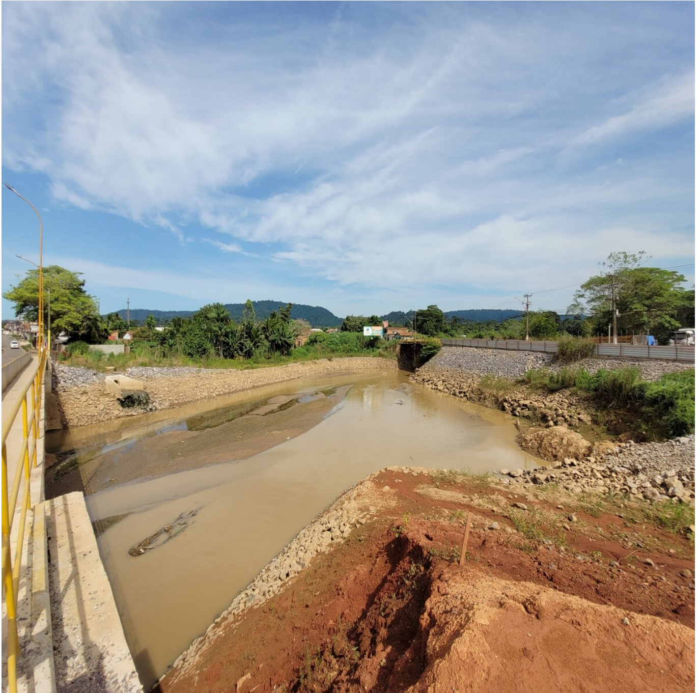
Obra de alargamento no igarapé ilha do coco.
